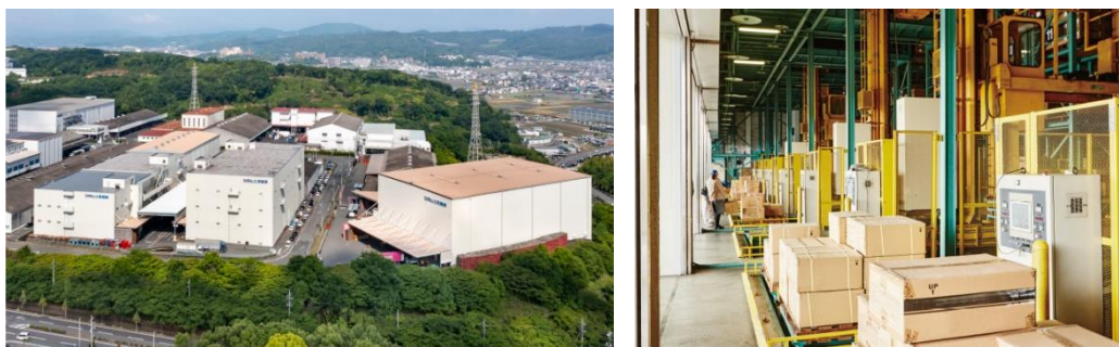
図表5. 流通センター営業所の外観
