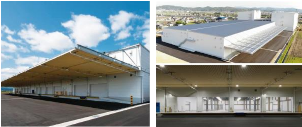
図表4. 第3倉庫の外観
