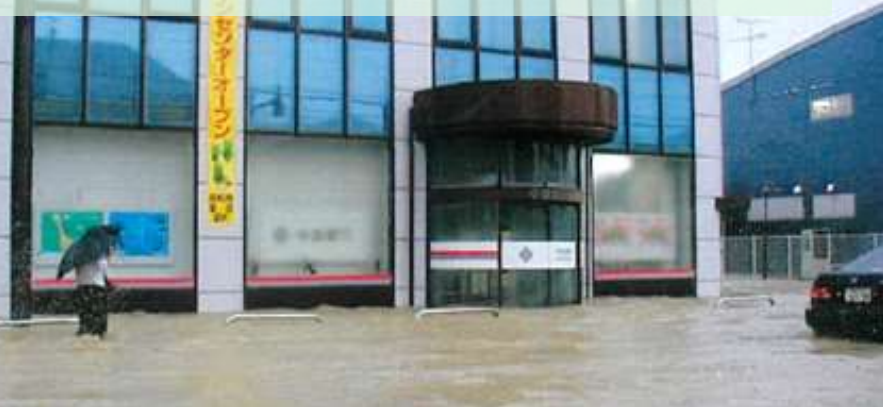
2004年台風23号での当行国分寺支店の被災状況 当行総務部保管記録より
