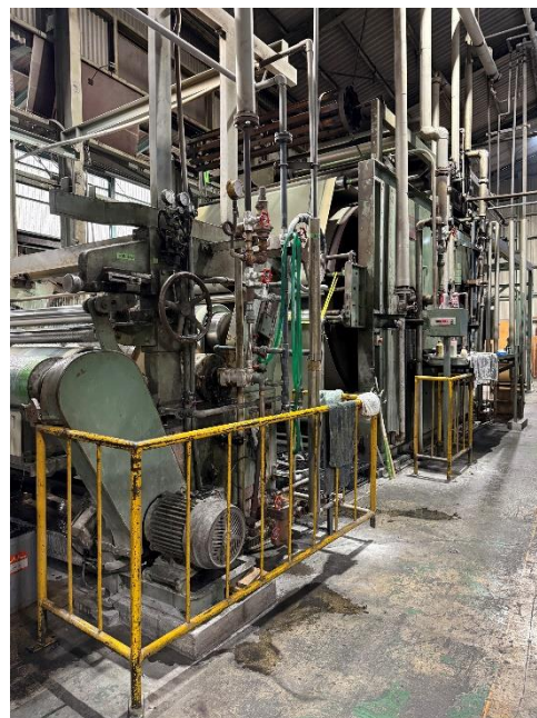
<2号機デニム仕上げ機>
